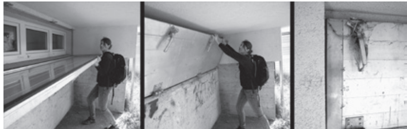
Abb. 3: Mobiles Hochwasserschutzzelement. ILAP 2017
